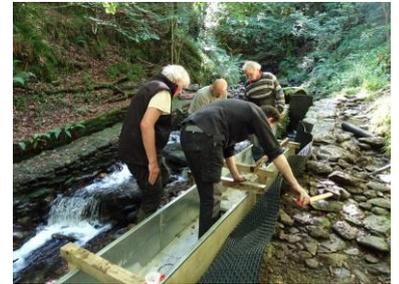
Le travail de finition (installation de la vanne de fuite, étanchéité,...) a été réalisé le 10 octobre par C. Savon, J.Paul et Colette. Il reste à refaire le seuil au niveau de la 2<sup>ème</sup> vanne.
